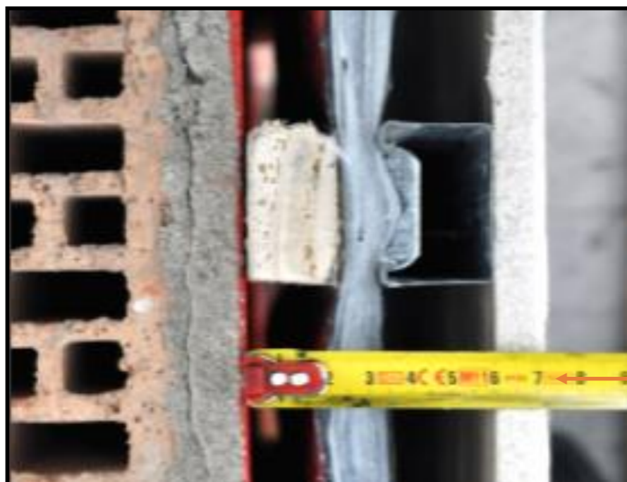
Parete isolata con Over-foil Multistrato 19 Spessore tot. controparete circa 7 cm
